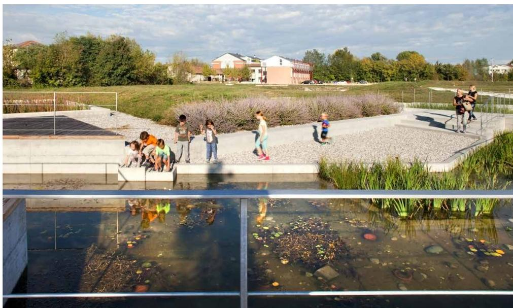
Le vasche per la fitodepurazione delle acque meteorologiche sono funzionali all'equilibrio idraulico caratterizzando una parte del giardino
