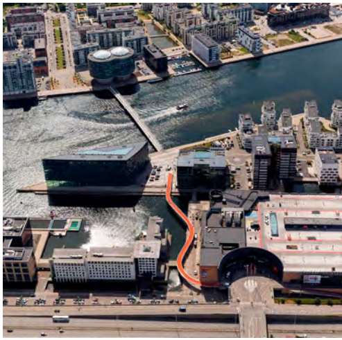
Figura 1– Vista aerea del Cykelslangen (The Bicycle Snake, 2014) e del Bryggebroen (Brygge Bridge, 2006), Copenhagen. Foto di Ole Malling.
