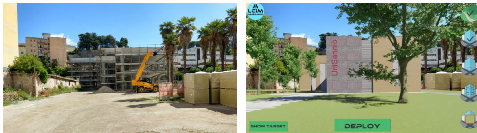
Fig. 1. Restituzione, mediante l'app Lcim progettata dal gruppo di ricerca Aurus, di uno spazio ibrido digitale in via dei Mulini a Benevento, attraverso la pre-figurazione del progetto architettonico del nuovo plesso dell'Università degli Studi del Sannio.
