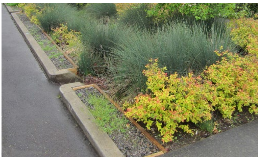
Fig. 1. Rain garden realizzato nel progetto "Tabor to the River", Portland (US) (fonte: sito istituzionale della città di Portland, Bureau of Environmental Services ( www.portlandoregon.gov/bes ).
