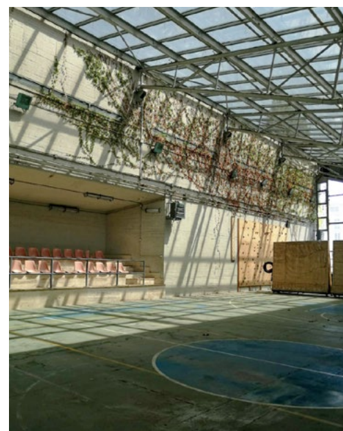
Fig. 1. Palestra del Centro polifunzionale (foto di Giorgia Arillotta).
