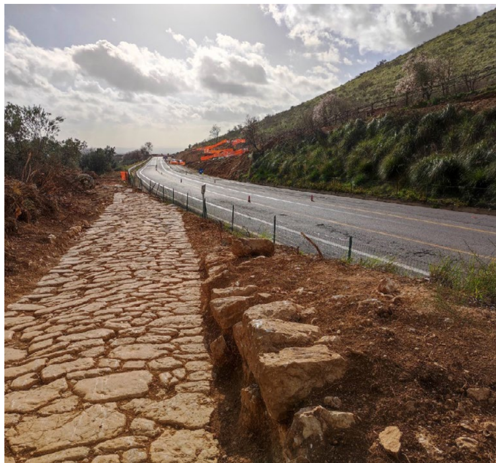
Fig.2. L'opportunità di scoperta e valorizzazione delle permanenze storiche che emergono nell'attuazione degli interventi di ammodernamento del tracciato; cantiere di ampliamento a tre corsie tra i km 47-49 della S.S.4 Salaria - Regione Lazio.
