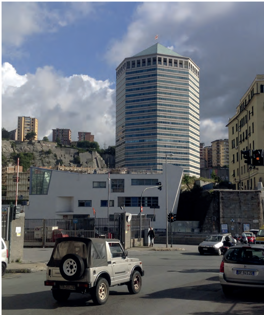
L'Associazione Genova Smart City ha promosso uno studio per ottimizzare il consumo di energia all'interno del grattacielo denominato "il Matitone" collocato in prossimità del Terminal traghetti. Lo studio è stato realizzato da Selex ES. Foto del 2016
