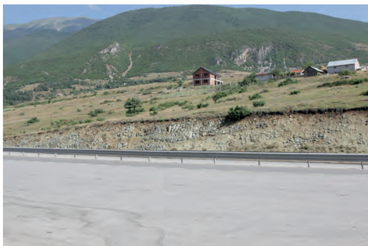
Vista del versante sud-est della valle attraversata dall'autostrada. Foto di Luca Pinnavaia
