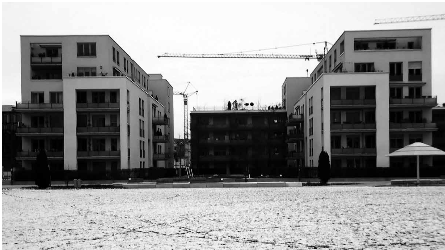
Recupero dei suoli ferroviari dismessi sulla linea Laim Pasing-Hauptbahnhof
