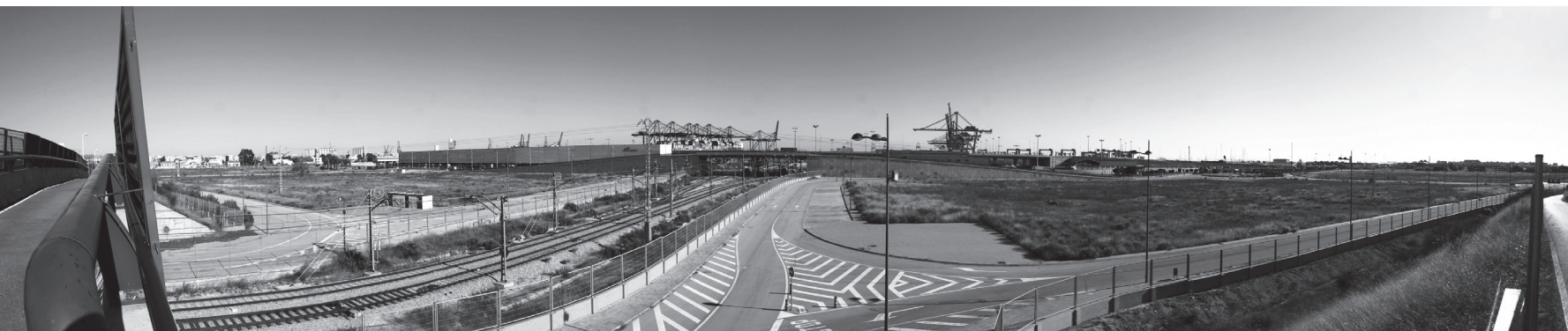
Vista panoramica della Zal di Valencia con le opere di urbanizzazione completate. (Fonte: Archivio fotografico dell'Autore, dicembre 2010)
