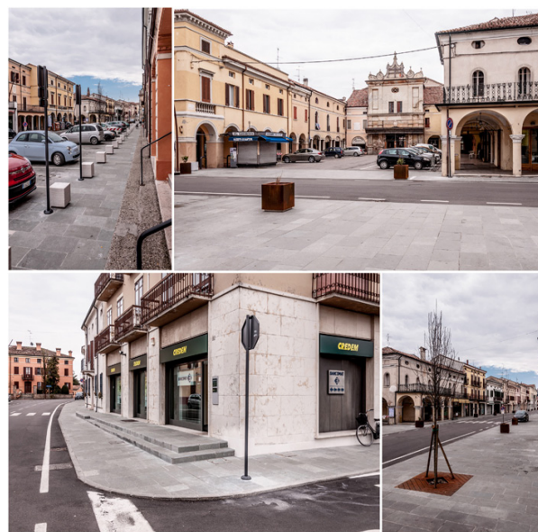
Dettagli di via Ferri a lavori ultimati.
