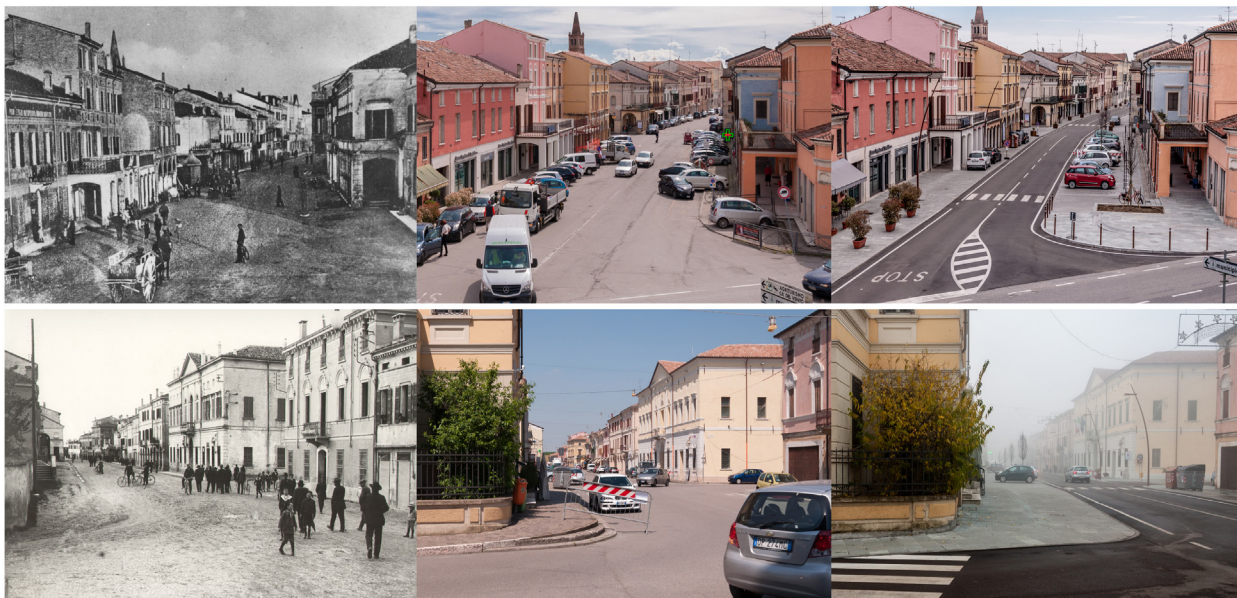
Via Enrico Ferri a inizio Novecento, prima dell'intervento e a lavori ultimati.
