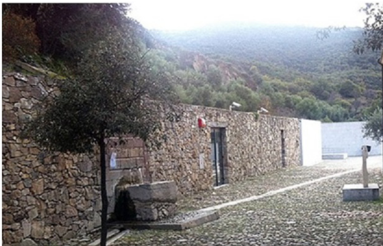
Stato di fatto. La pavimentazione esistente in acciottolato non assicura accessibilità ai servizi e alle diverse parti del museo.
