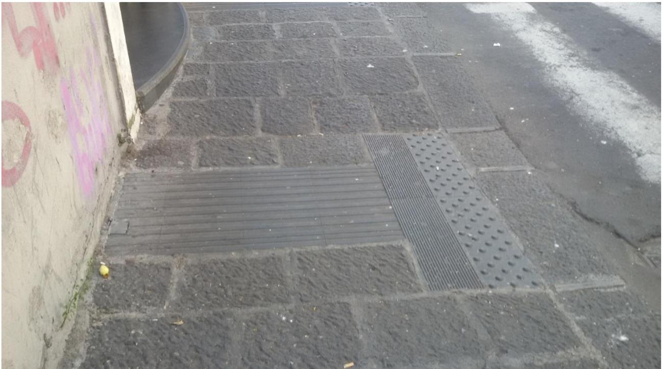
I percorsi tattili finiscono erroneamente nel muro senza segnalare l'ostacolo, via Vittorio Emanuele
