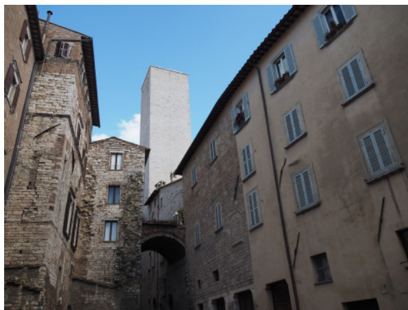
Alloggi sociali della Torre degli Sciri, Perugia. Fonte: Ater Umbria.
