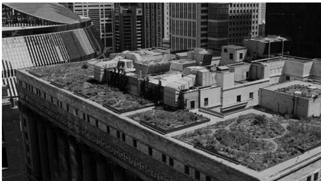
Il "green roof" realizzato alla sommità della Chicago City Hall
