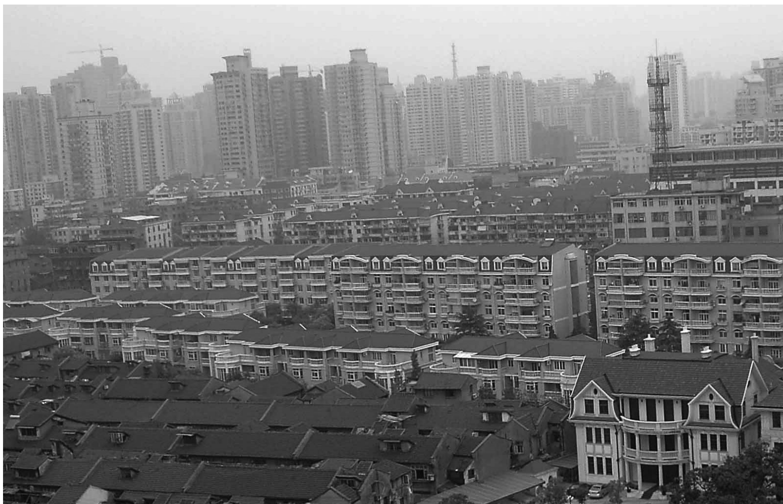
Urbanizzazione vicino al fiume Suzhou, parte nord di Puxi, in primo piano i vecchi edifici in via di demolizione.
