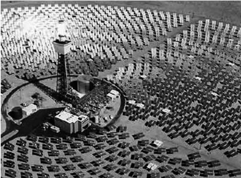
detti eliostati, riflette la radiazione solare incidente concentrandola in un ricettore. Ivi il fluido termovettore, generalmente una miscela di sali fusi, trasferisce il calore recepito ad uno scambiatore ove avviene la vaporizzazione dell'acqua e la produzione di energia elettrica. Ovviamente il vapore, all'uscita della turbina, viene sottoposto a
