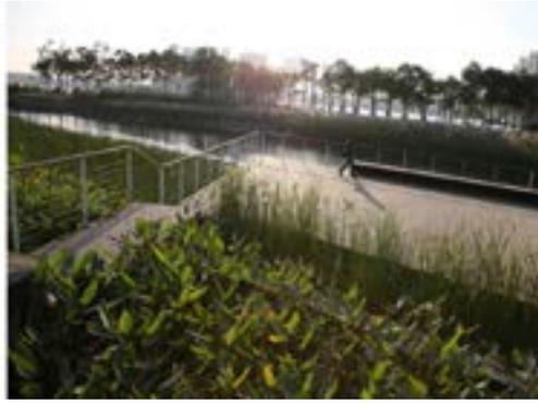
Figura 2- La zona umida terrazzata è fortemente piantumata per depurare l'acqua contaminata. La struttura a terrazze degradanti permette alle persone di accedere all'acqua e fruire della vista verso il contesto circostante
